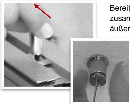
Bereiten Sie die Deckenhänger vor, indem Sie diese mit den Nutensteinen zusammen schrauben. Schieben Sie die Deckenhänger anschließend in die äußere Nut des letzten Profils und drehen Sie diese Fest.
