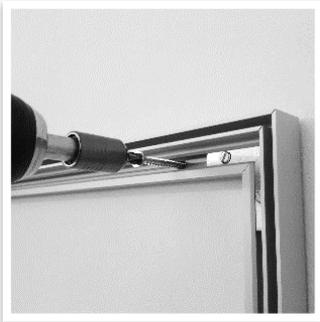
Halten Sie den Rahmen an die Wand und markieren Sie mit einem Bleistift die Stellen für die Bohrungen. Bohren Sie dort Löcher in die Wand und stecken Sie die entsprechenden Dübel hinein. Anschließend befestigen Sie den Rahmen mit Schrauben.
